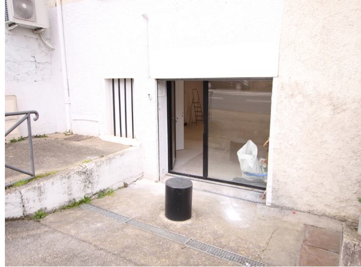
Route de Paris, murs commerciaux de 50 m 2 à aménager équipé d'un point d'eau avec lavabo et wc et d'une climatisation réversible.
